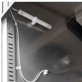
Feuchtigkeitskontrolle mit elektronischer Sonde
