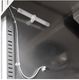
Feuchtigkeitskontrolle mit elektronischer Sonde
