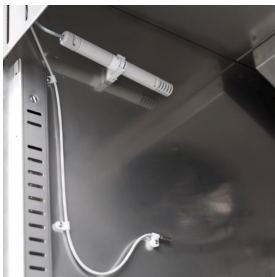
Feuchtigkeitskontrolle mit elektronischer Sonde
