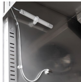
Feuchtigkeitskontrolle mit elektronischer Sonde
