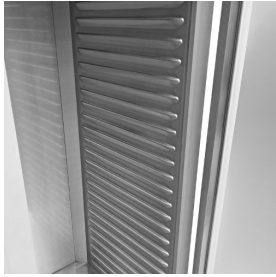
Detail der geprägten Edelstahl-Innenräume
