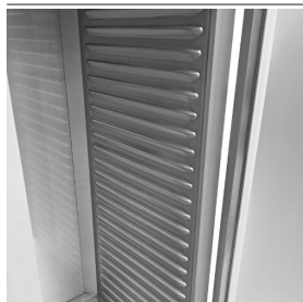
Detail der geprägten Edelstahl-Innenräume
