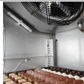
Elektronische Sonde zur Erfassung der relativen Luftfeuchtigkeit
