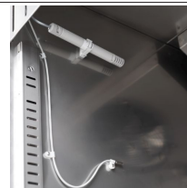
Feuchtigkeitskontrolle mit elektronischer Sonde
