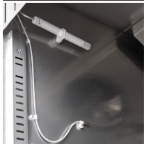
Feuchtigkeitskontrolle mit elektronischer Sonde
