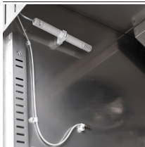
Feuchtigkeitskontrolle mit elektronischer Sonde
