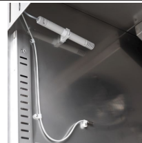
Feuchtigkeitskontrolle mit elektronischer Sonde
