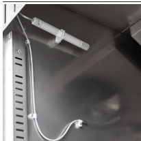
Feuchtigkeitskontrolle mit elektronischer Sonde
