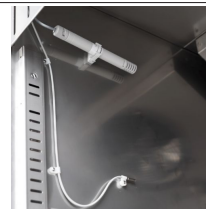
Feuchtigkeitskontrolle mit elektronischer Sonde
