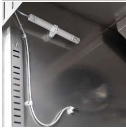
Feuchtigkeitskontrolle mit elektronischer Sonde
