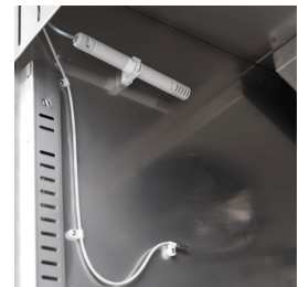
Feuchtigkeitskontrolle mit elektronischer Sonde
