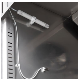
Contrôle de l'humidité avec une sonde électronique
