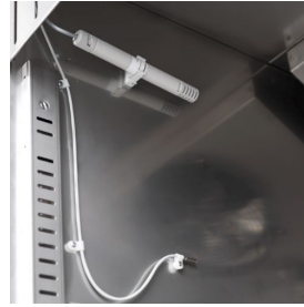
Contrôle de l'humidité avec une sonde électronique
