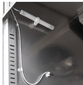
Contrôle de l'humidité avec une sonde électronique
