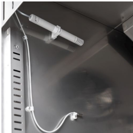
Contrôle de l'humidité avec une sonde électronique
