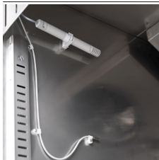
Contrôle de l'humidité avec une sonde électronique
