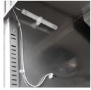
Contrôle de l'humidité avec une sonde électronique
