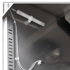
Contrôle de l'humidité avec une sonde électronique
