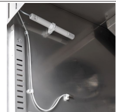
Contrôle de l'humidité avec une sonde électronique
