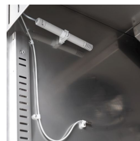
Contrôle de l'humidité avec une sonde électronique
