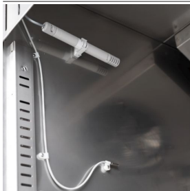
Contrôle de l'humidité avec une sonde électronique
