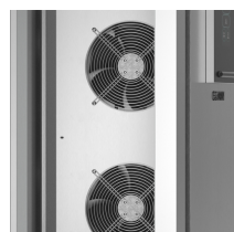
Contrôle de la ventilation à toutes les phases
