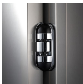
Détail de la charnière de porte battante
