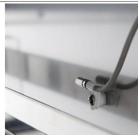
Sonda interno cella per il controllo costante della temperatura
