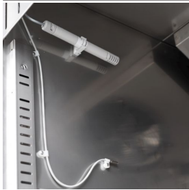
Controllo dell'umidità con sonda elettronica
