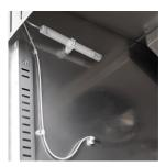
Controllo dell'umidità con sonda elettronica
